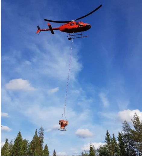
Bild 1. Utlägg av grus i Dainabäcken. Magnus Lindberg, Länsstyrelsen Västerbotten.
