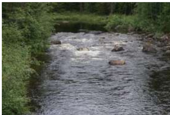
Bild 12: ovanför bron efter åtgärd.
