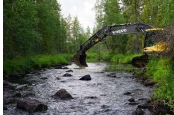
Bild 12: Grävmaskinen lägger ut lekgruset
