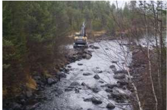
Bild 9: Utlopp under pågående åtgärd
