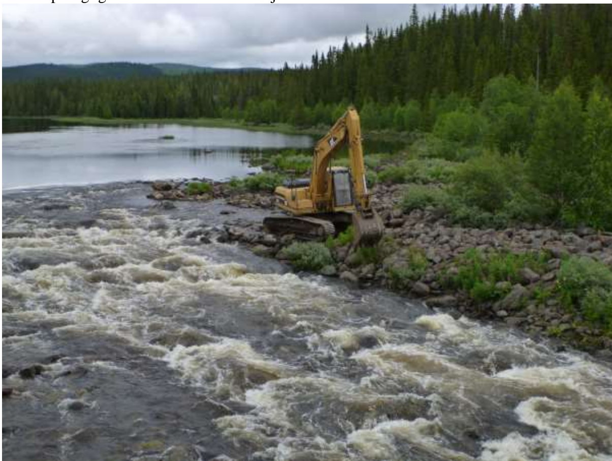
Med hjälp av grävmaskinen återförs block och sten vid Fatsjöluspen, Marsån.
