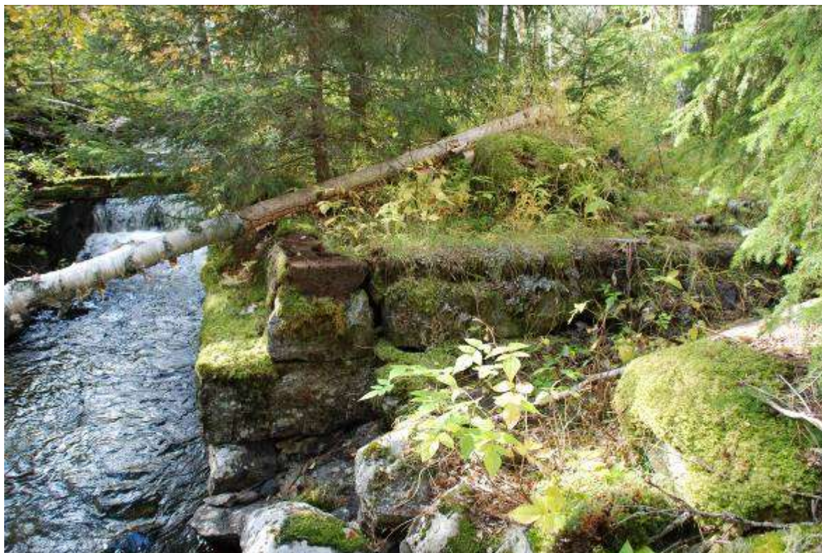
Kraftverksgrunden med stensatt vattenkanal innan den röjdes.
