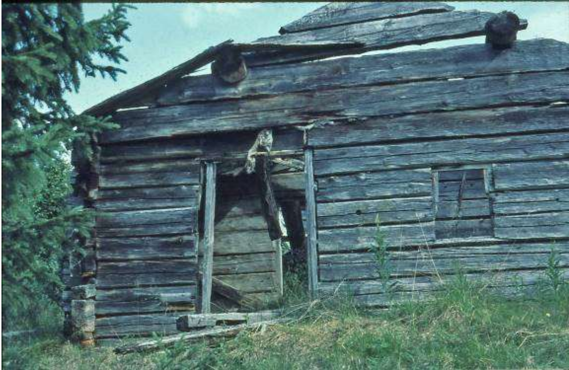
Timmerstommen på skifte Bh. Bilden tagen 1962. Nu återstår endast rester. Märkning inne i den förfallna timmerstommen MCS 1834
