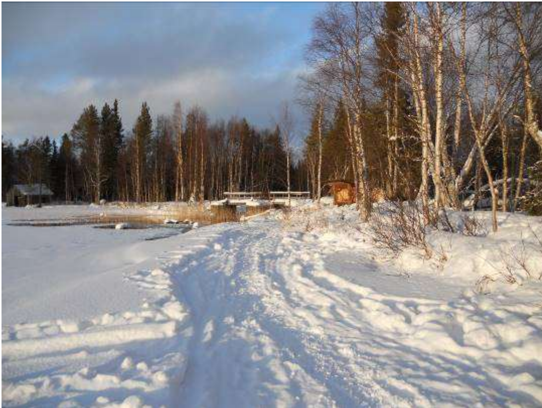
Skyddet ligger i direkt anknytning till dammanläggningen. Med möjlighet till passage över dammen kan man komma nära skyddet med snöskoter
