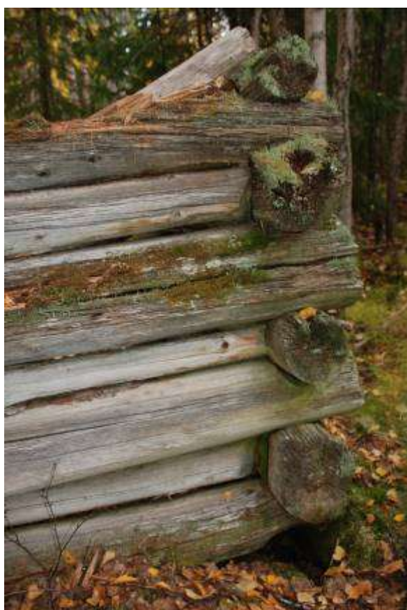
Hölada timrad med fyllstock mellan väggstockarna.
