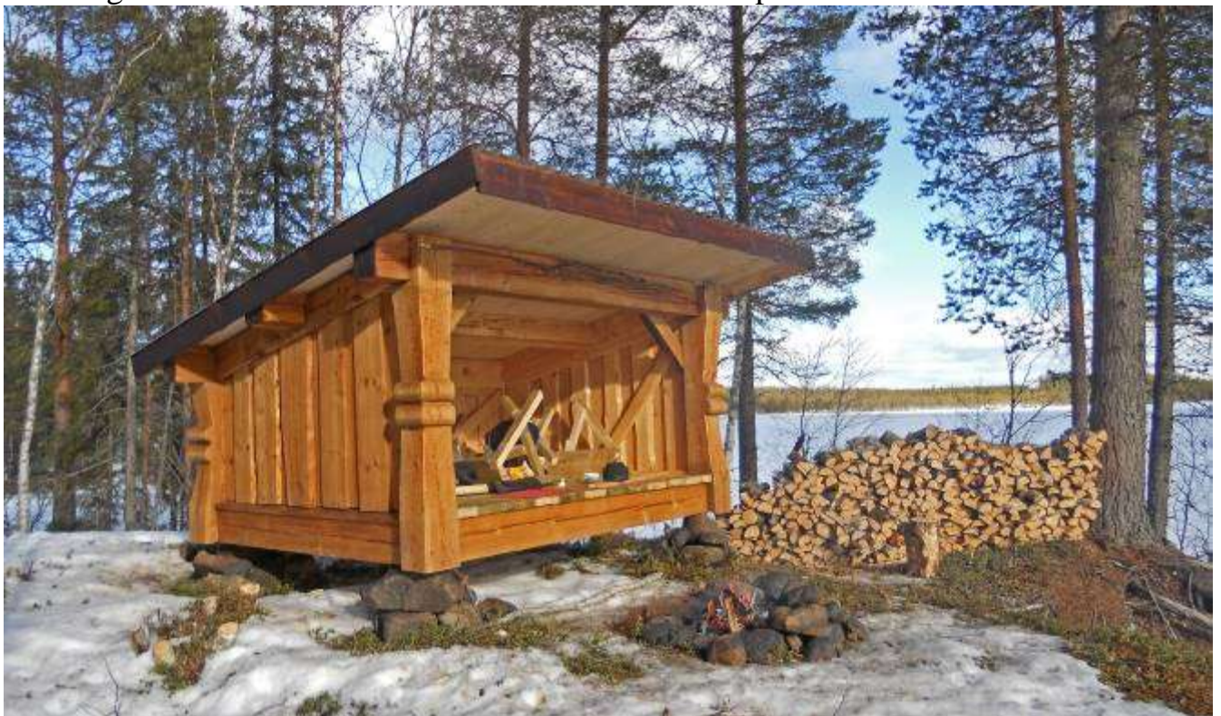
Skyddet färdigt med nytjärade vindskivor redo att användas av alla besökare. Veden ska staplas under takutskicken på sidorna när den torkat till försommaren.
