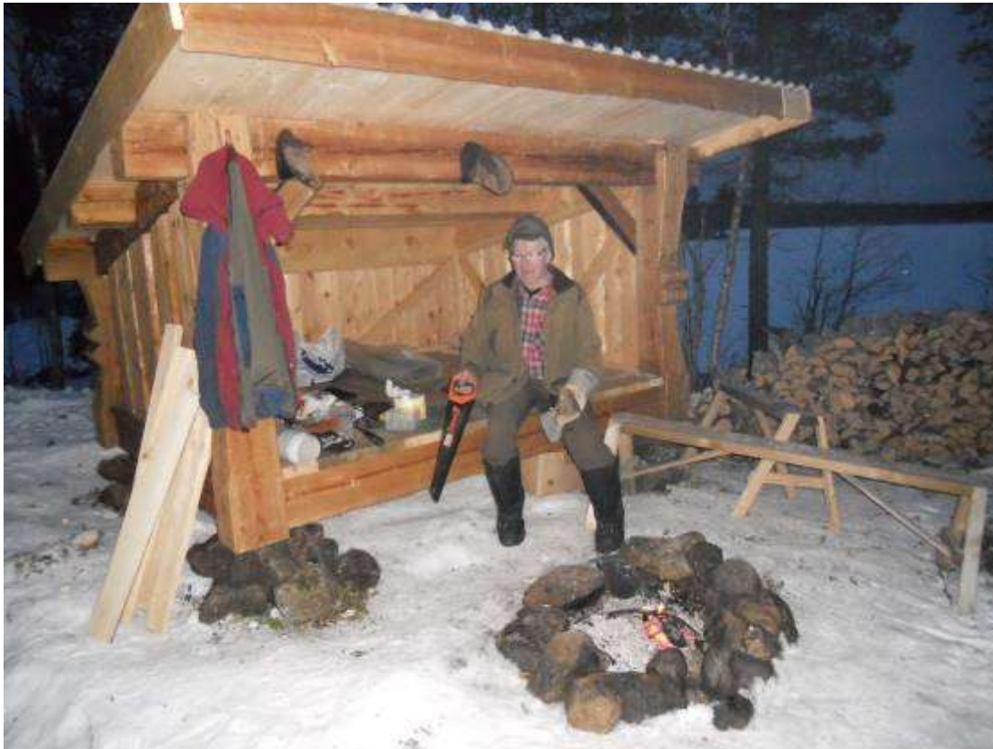
Det drog mot kvällen och mörker när sista vindskivan spikades fast.
